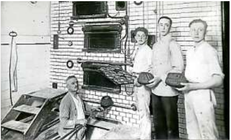
Mühsam: Um die untere Etage des Backofens zu nutzen, musste Jean Stierstädter zuerst in eine Grube steigen. Foto/Repros: Maik Reuß
